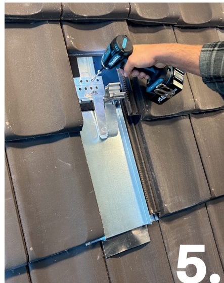
5. Dachhaken montieren.
