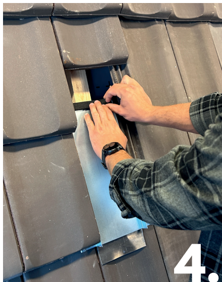
4. Dichtband anbringen.
