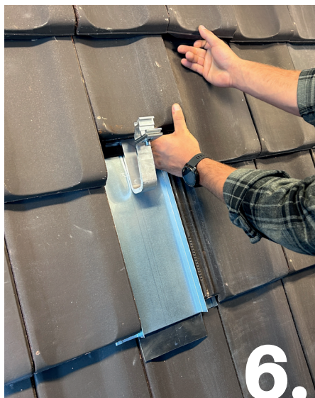
6. Dachziegel eindecken.
