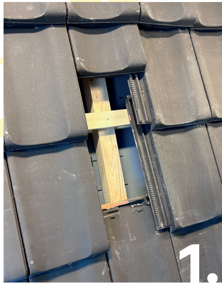
1. Dachziegel freilegen.
