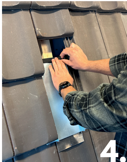
4. Dichtband anbringen.
