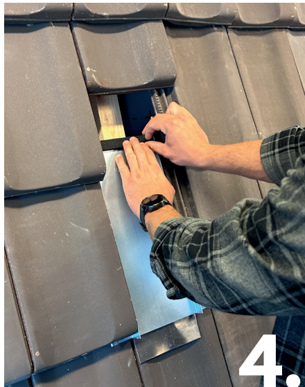
4. Dichtband anbringen.
