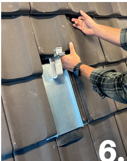
6. Dachziegel eindecken.
