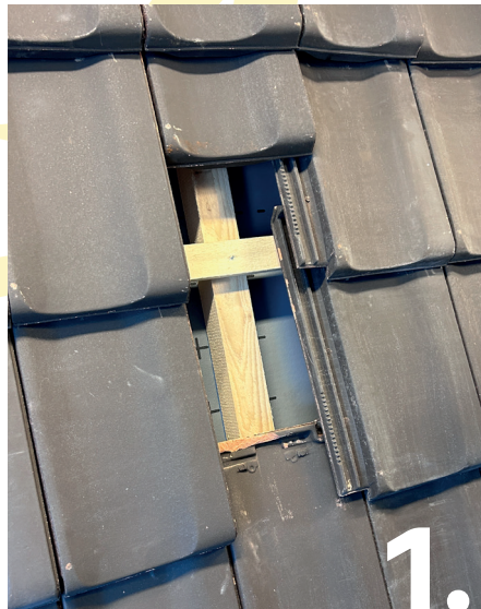
1. Dachziegel freilegen.
