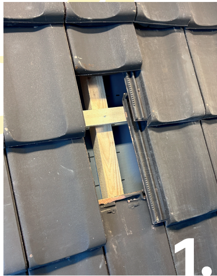
1. Dachziegel freilegen.
