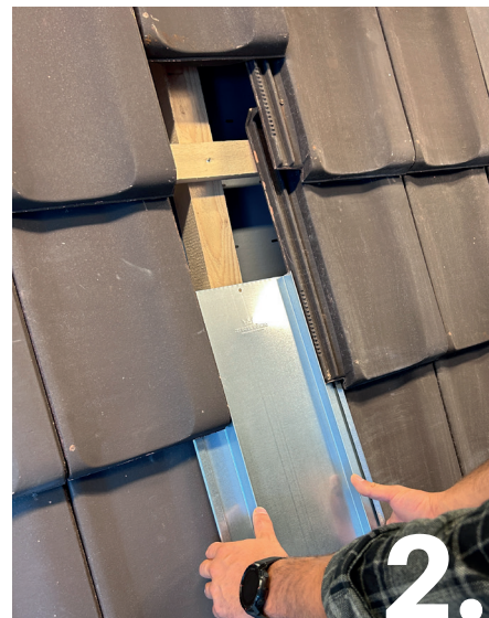
2. Blechziegel von Ziegel König einsetzen.
