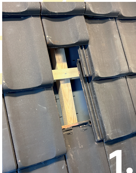
1. Dachziegel freilegen.
