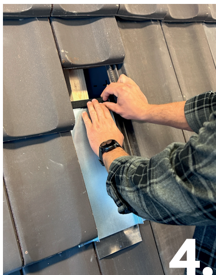
4. Dichtband anbringen.
