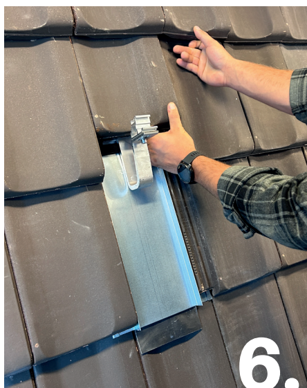
6. Dachziegel eindecken.
