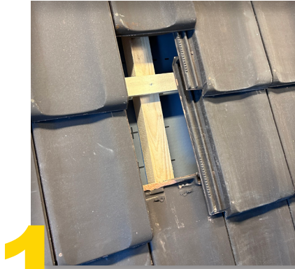
1 Dachziegel freilegen
