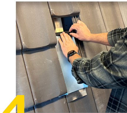
5 Dachhaken montieren
