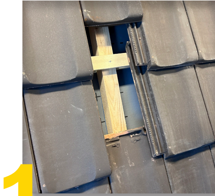
1 Dachziegel freilegen
