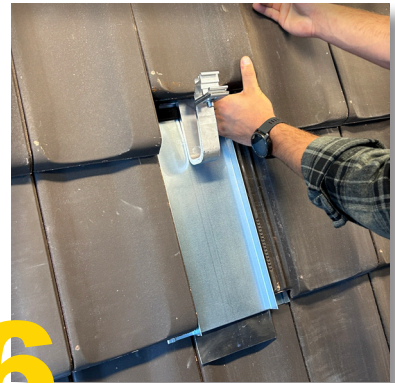
3 Blechziegel mittels Dichtschraube auf den Dachlatten befestigen
