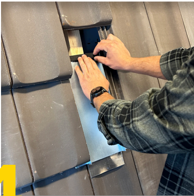
5 Dachhaken montieren
