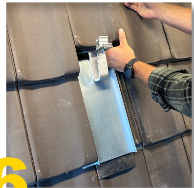
3 Blechziegel mittels Dichtschraube auf den Dachlatten befestigen
