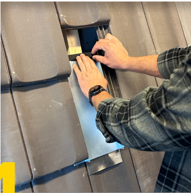
5 Dachhaken montieren
