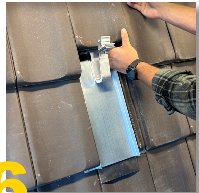
3 Blechziegel mittels Dichtschraube auf den Dachlatten befestigen
