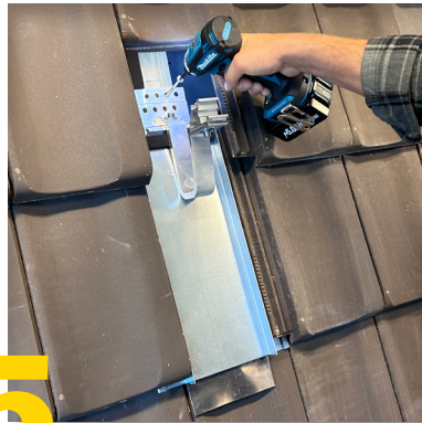
6 Dachziegel eindecken
