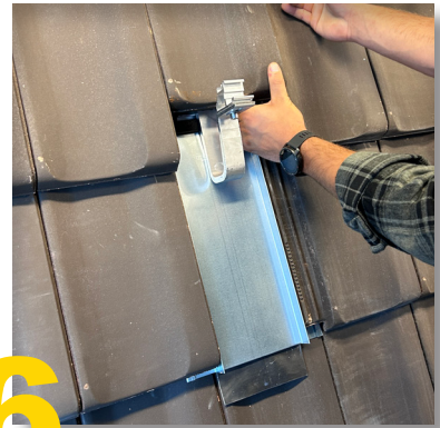
3 Blechziegel mittels Dichtschraube auf den Dachlatten befestigen
