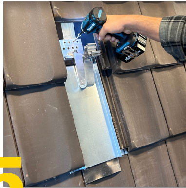
6 Dachziegel eindecken
