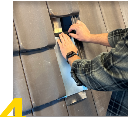
5 Dachhaken montieren
