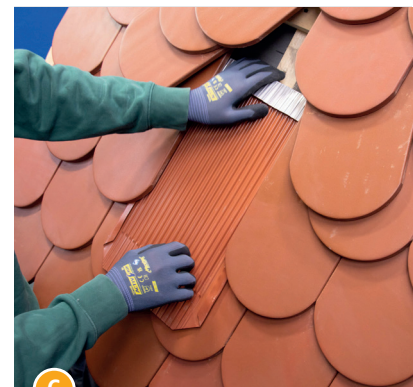
6 Prüfen, ob die Ausparung des Stützblechs auf der oberen Querlatte eingehängt ist.
