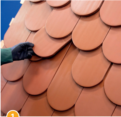
1 Dacheindeckung im Montagebereich ausdecken und die äußeren Dachplatten...
