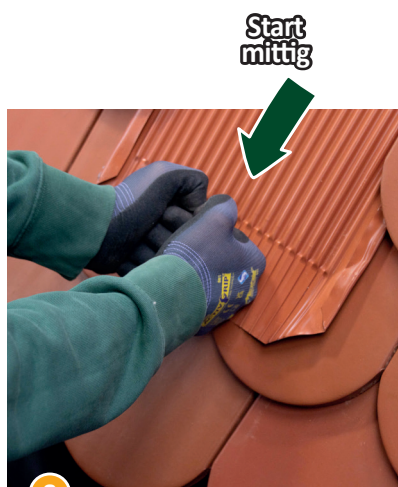
8 Biber-Platte beginnend von der Mitte nach außen fest und formschlüssig andrücken.
