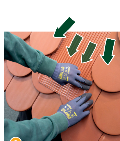
9 Dabei wieder darauf achten, dass sich im mittleren und oberen Bereich keine Wassersäcke bilden.
