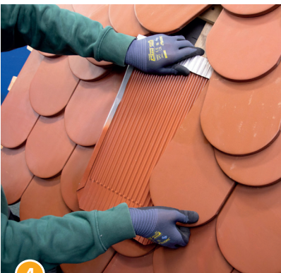
4 Rechten Ziegel anheben und Biber-Platte darunter schieben.
