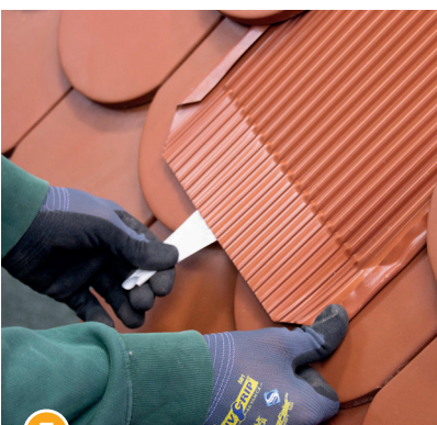
7 Schutzfolie des Klebestreifens auf der Unterseite der Beta-Platte komplett abziehen.
