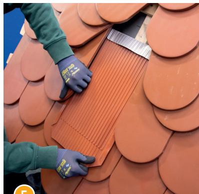
5 Linken Ziegel anheben und über die Biber-Platte legen.
