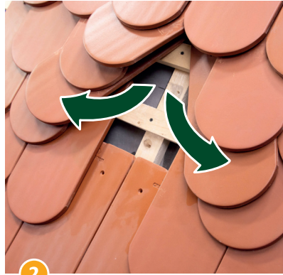
2 ...unter der oberen Reihe so platzieren, dass die Querlattung gut einseh- und erreichbar ist.
